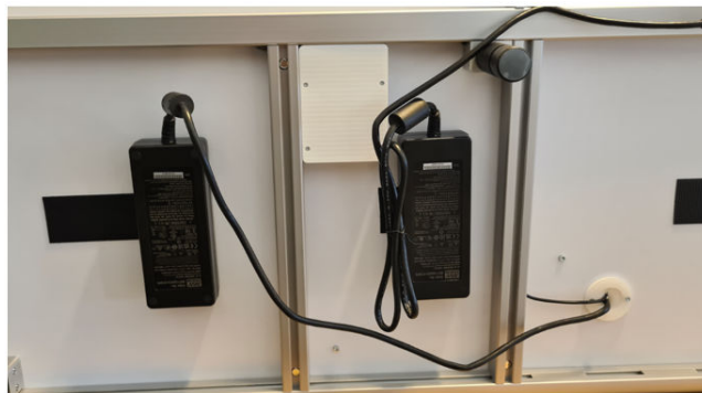
Figure 2–12 : Installation de l'alimentation électrique Andrew+
