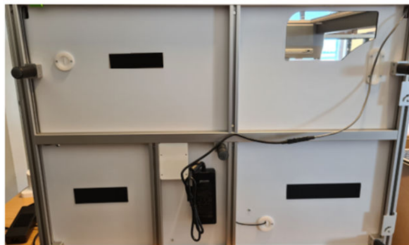
그림 2-11: 외부 전원 공급 장치 설치
