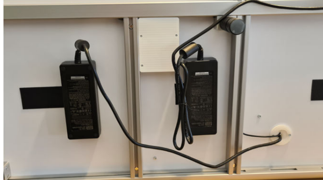
그림 2-12: Andrew+ 전원 공급 장치 설치
