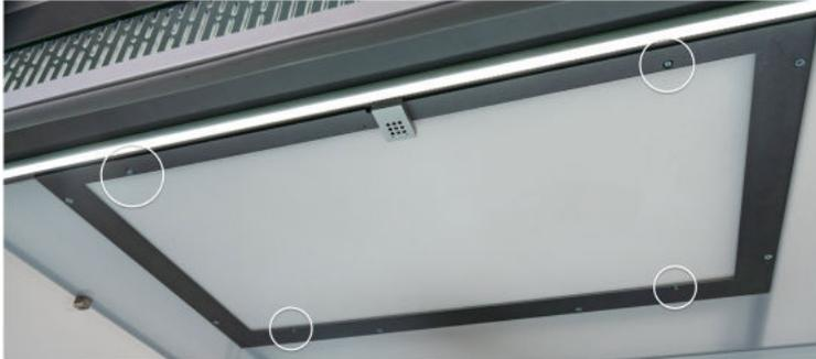
2. Abra o módulo do pré-filtro e verifique se o filtro está montado corretamente.
